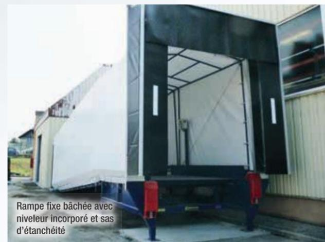
Rampe fixe bâchée avec niveleur incorporé et sas d'étanchéité
