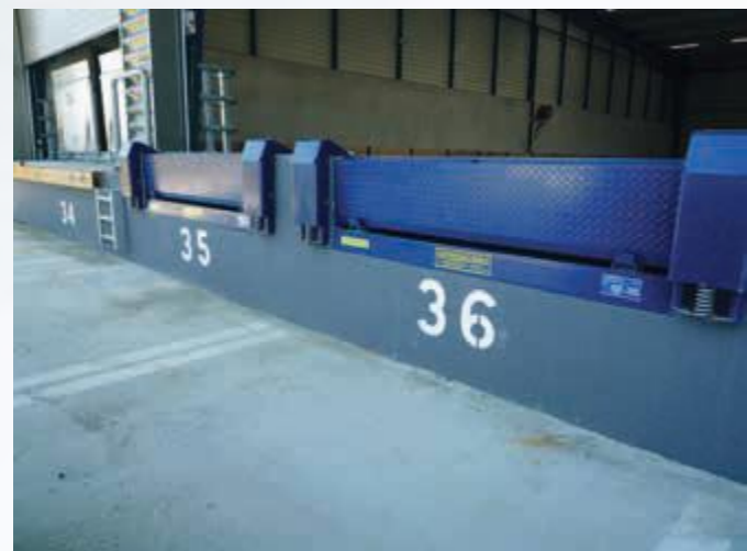
Charnières de levre oxycoupées très résistantes en forme de gouttes d'eau : Plus la charge utile du niveleur augmente et plus le nombre de charnières est grand.
