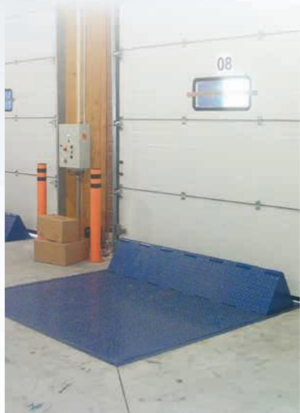
La zone refuge, permet de protéger une personne imprudente de l'écrasement, ici par exemple, le deuxième chauffeur qui va frapper à la porte d'un entrepôt alors que son collègue recule pour se mettre à quai.
